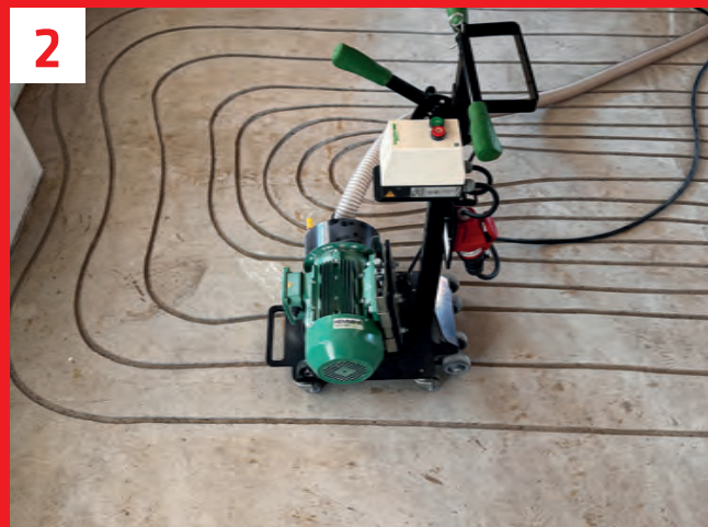
Mit unserer Fräsmaschine fräsen wir die Kanäle für unser Heizrohr in den zuvor von unserer Planungsabteilung festgelegten Verlegeabständen.
