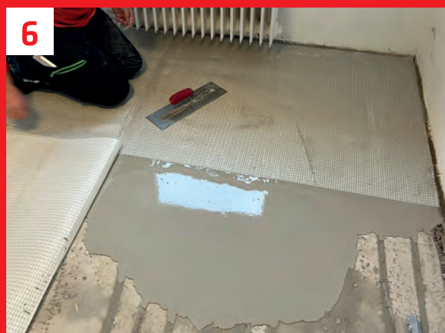
In mehreren Arbeitsgängen werden verschiedene Spachtelmassen aufgetragen und eine Entkoppelungsmatte eingearbeitet. Nach einer kurzen Trocknungsphase kann bereits mit der Verlegung der Oberbeläge begonnen werden.
