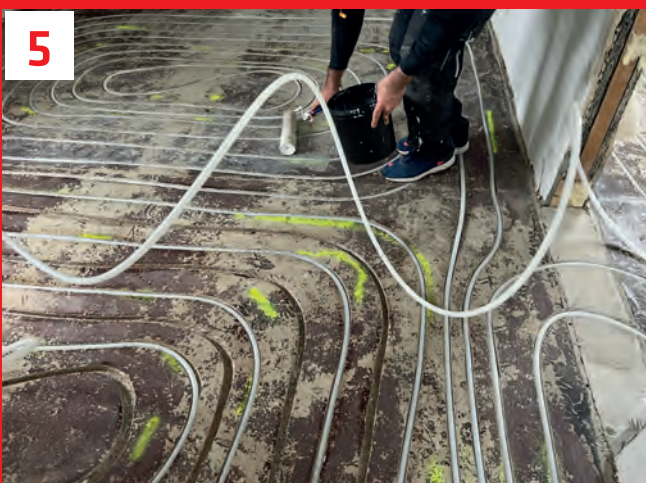
Nach einer Grundierung wird das Heizrohr verlegt. Hierbei handelt es sich um unser vollwertiges Fußbodenheizrohr ATHE-Middle. Bei ATHE-CUT iN gibt es keine Kompromisse bei Leistung und Qualität.
