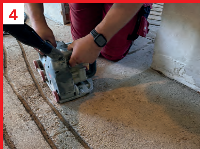
Die Anschlüsse direkt vor dem Heizkreisverteiler können mittels einer Handfräse passgenau ausgeführt werden.
