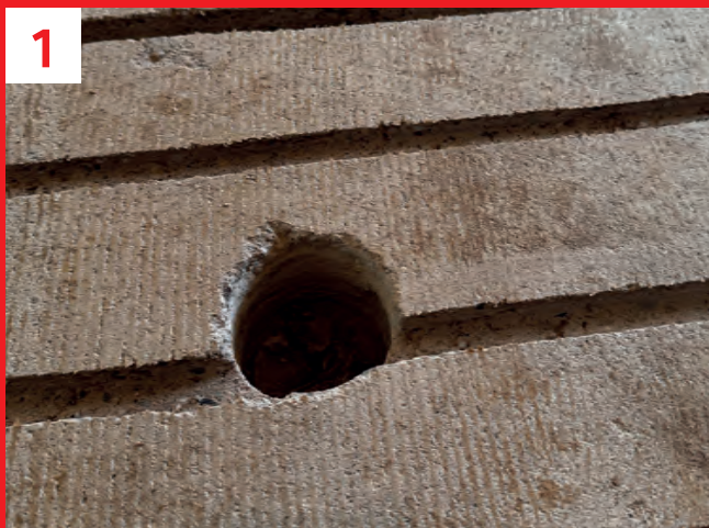
Vor der Montage prüft unser Techniker durch mehrere Bohrproben, ob der vorhandene Untergrund geeignet ist.
